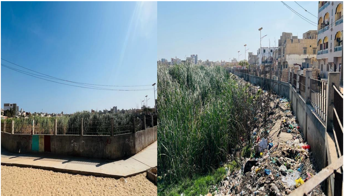
Photo 8 : BASSIN de RETENTION (végétation et ordures ménagères)
